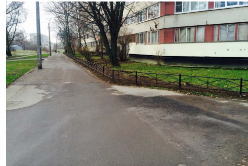
ул. Пионерстроя, д.19 к.2
