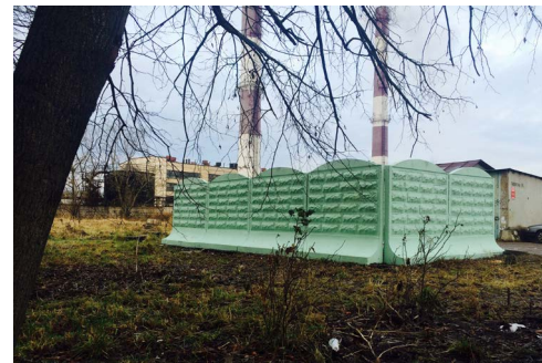
ул. Пионерстроя, д.19 к.2-3
