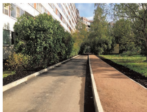
ремонт проезда ул. Тамбасова д.4 к.2
