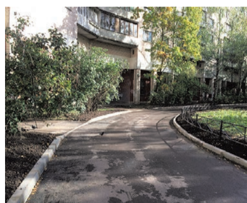
ремонт асфальтобетонного покрытия пожарного проезда ул. Тамбасова д.4 к.2
