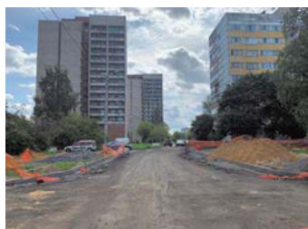
ул. Здоровцева, д.10, процесс работ
