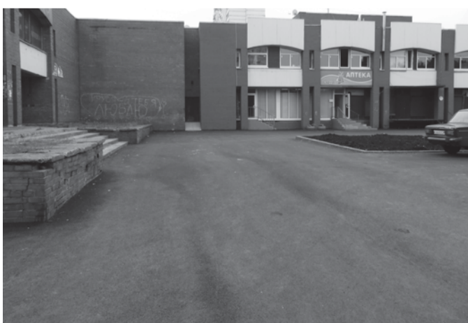
Асфальтирование. Ул. Тамбасова, д. 4
